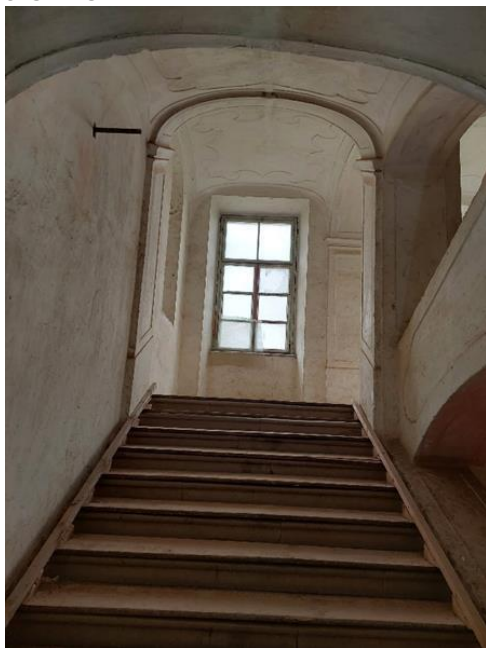
SLIKA 4: POGLED NA STOPNIŠČE S POZNOBAROČNIMI ŠTUKATURAMI
