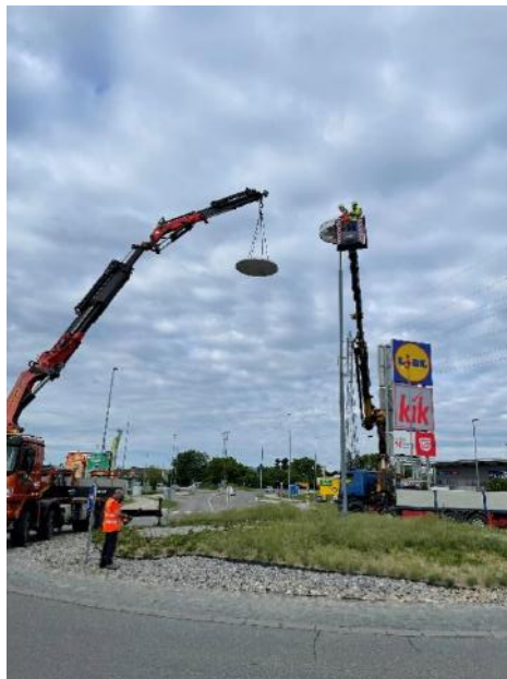
Dvig profila krošnje (levo) in menjava svetilk javne razsvetljave v krožišču industrijske cone Bistrica (desno)
