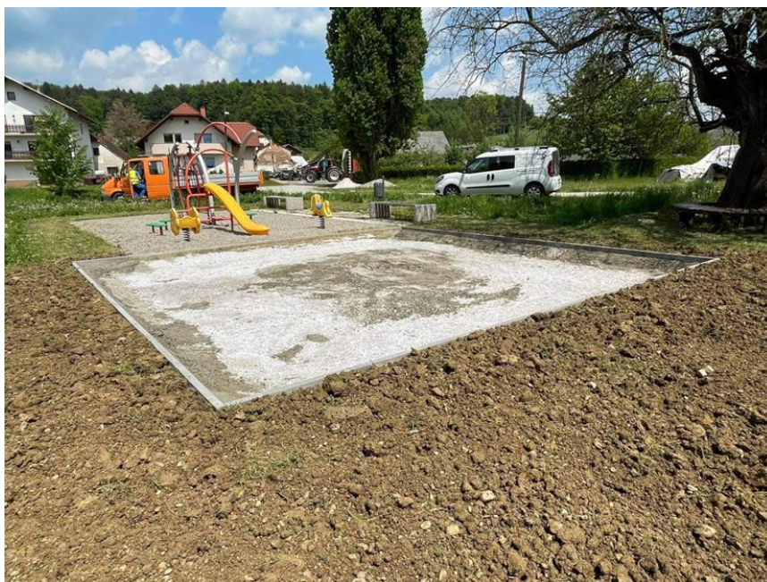
Gradbena dela za izdelavo igral na Spodnji Ložnici
