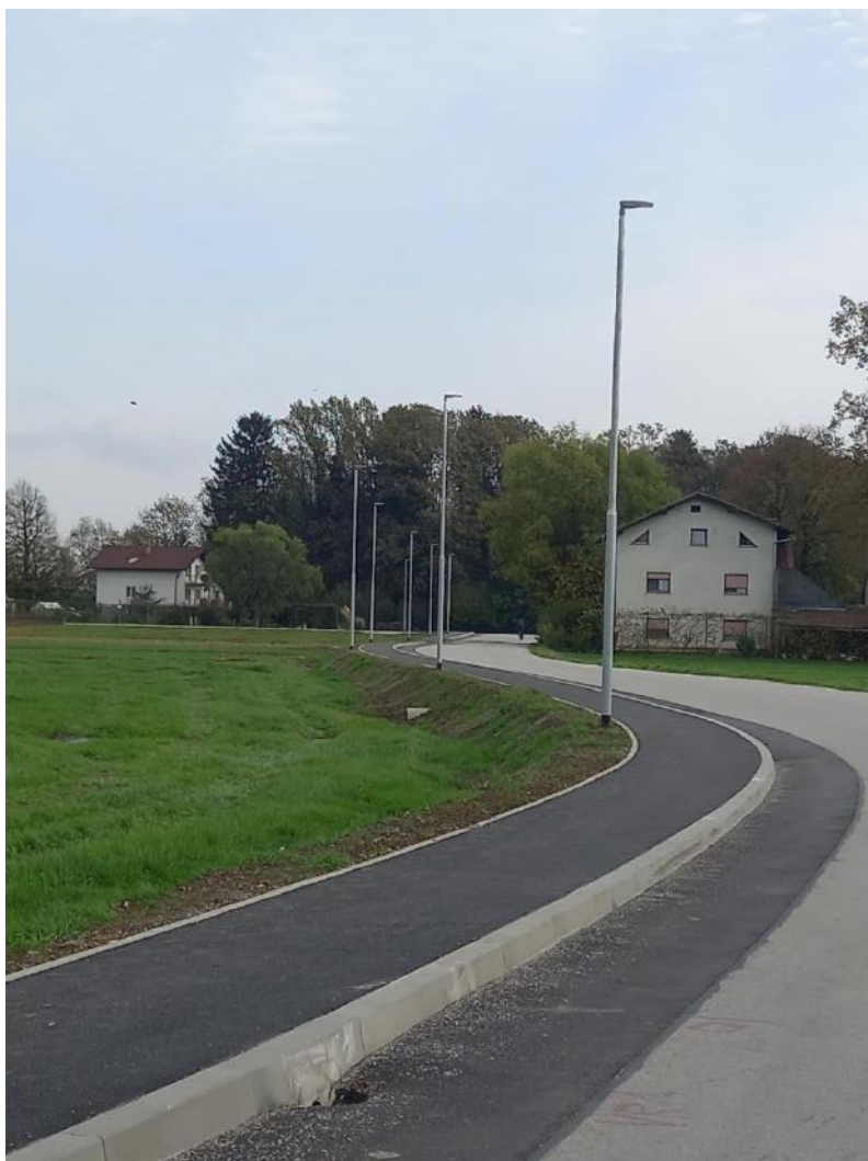
Izgradnja pločnika v Starem Logu
