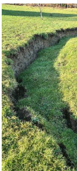
Sanacija vodovoda zaradi plazu
