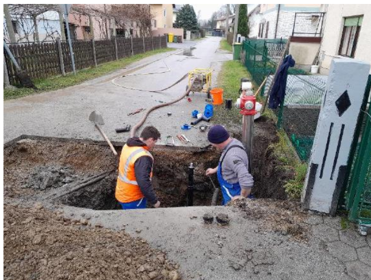
Montaža novega hidranta za KS Pragersko
