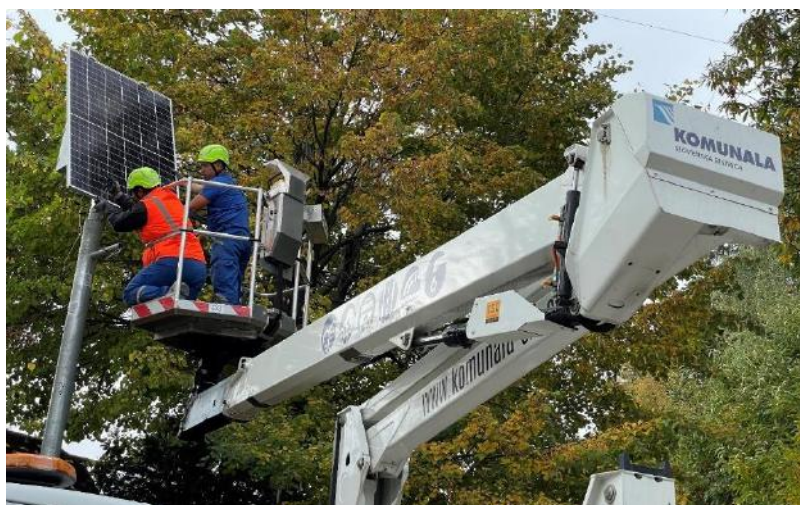
Montaža solarne svetilke
