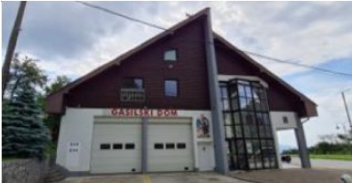
Slika 5: Prikaz objekta Večnamenski objekt Kebelj
