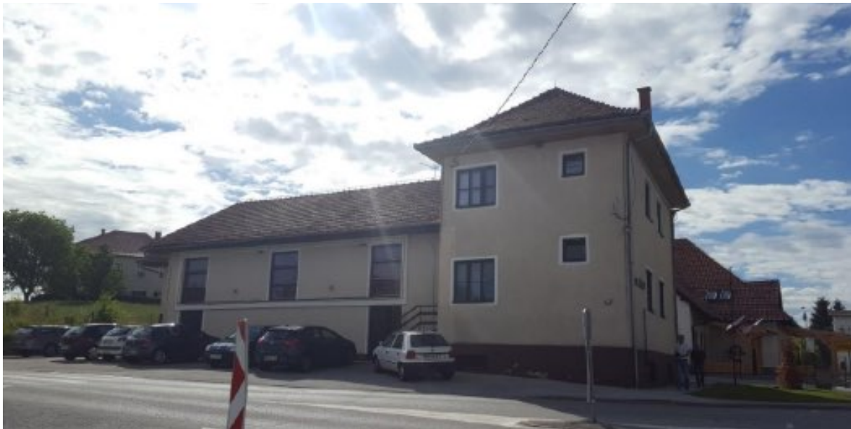
Slika 7: Prikaz objekta Dom kulture Črešnjevce
