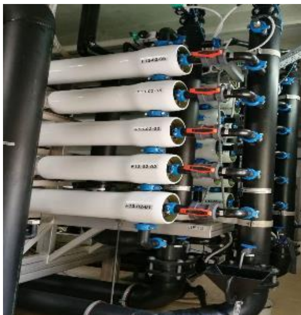
Slika 43: Ultrafiltracija pitne vode
