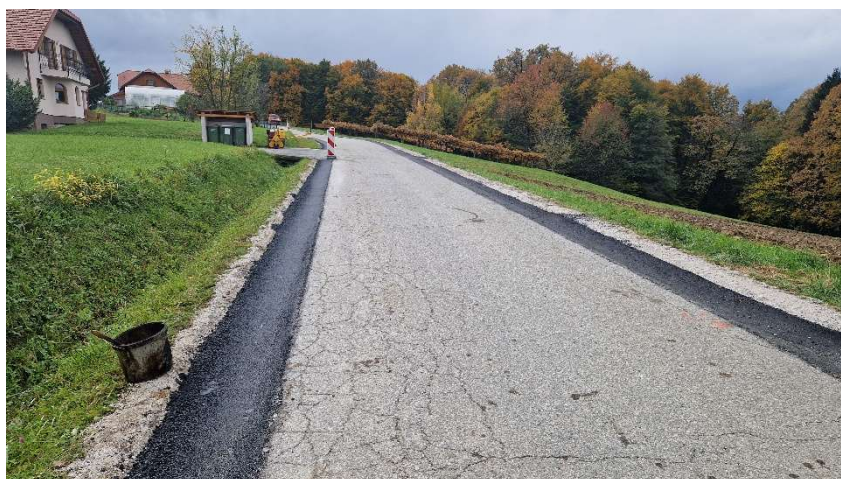
Izdelava asfaltnih muld na lokalni cesti Laporje - Hošnica
