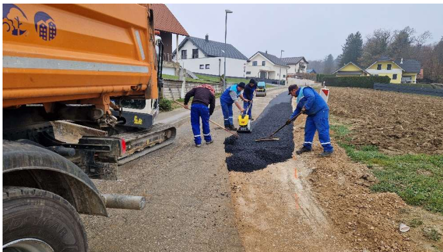
Ročno asfaltiranje razširitve vozišča na lokalni cesti
