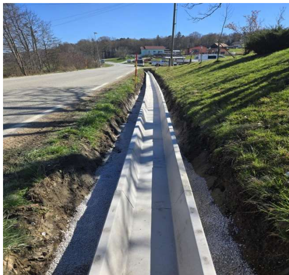
Ureditev odvodnjavanja na lokalni cesti Slovenska Bistrica - Pečke
