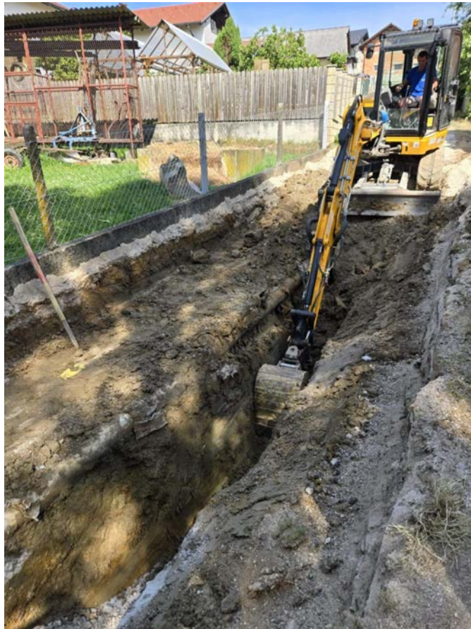
Izgradnja kanalizacijskega omrežja na Zgornji Polskavi
