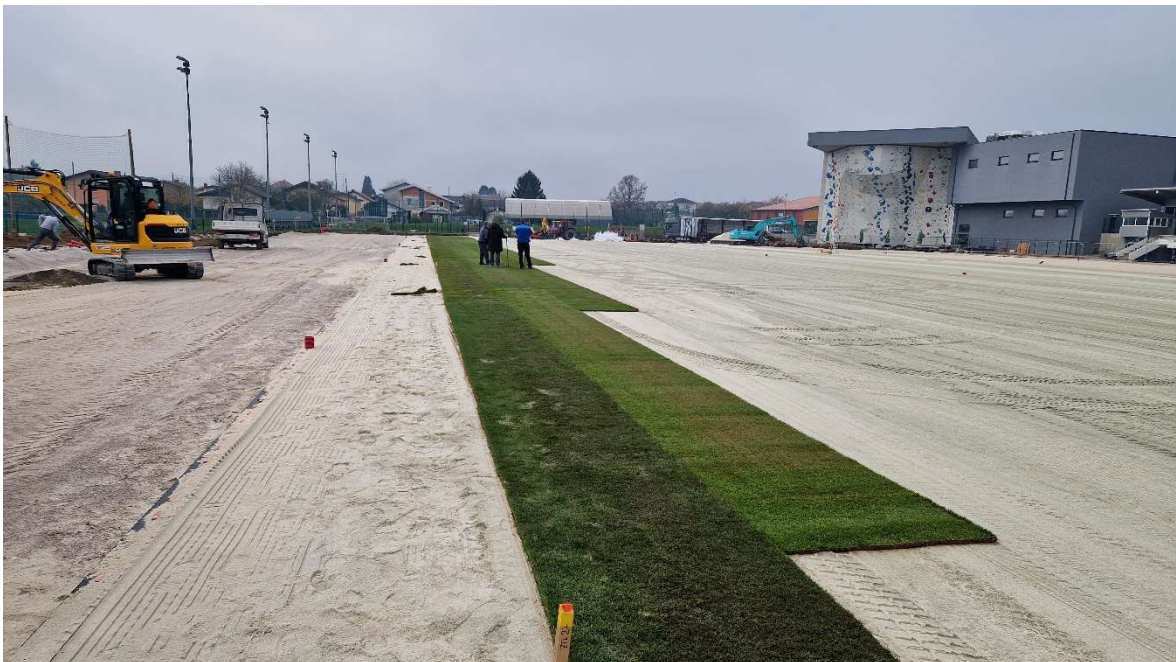
Izgradnja atletskega stadiona in nogometnega igrišča
