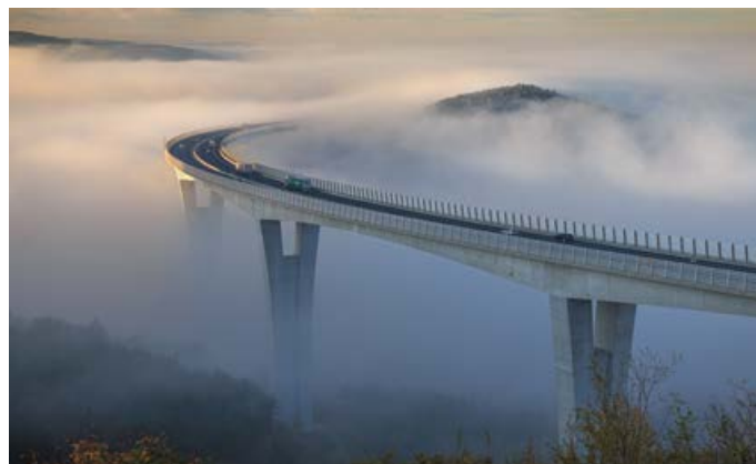
Viadukt Črni kal, foto: osebni arhiv
